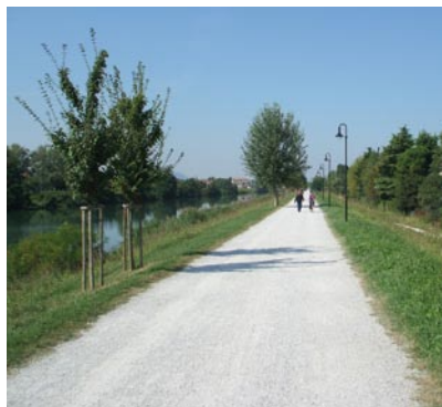
Padova, cycle/pedestrian path on the Canale Scaricatore
