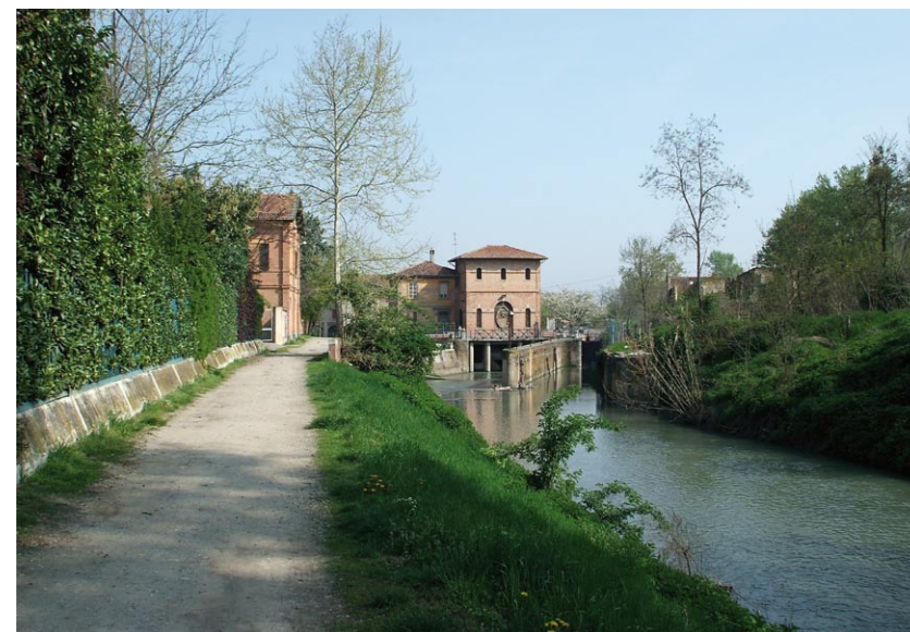
Bologna, Sostegno Battiferro
